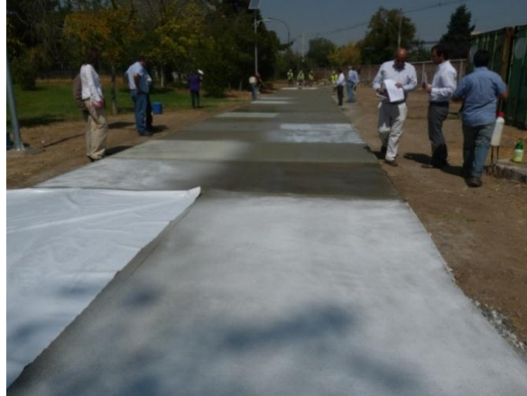
Figura 3: Pavimento de hormigón con aplicaciones de curado.
