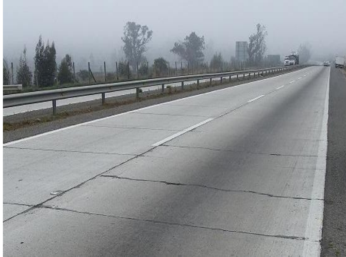
Figura1. Ruta 78 Sección D (Km 90.000 a Km 92.930) pavimentado durante el día.
